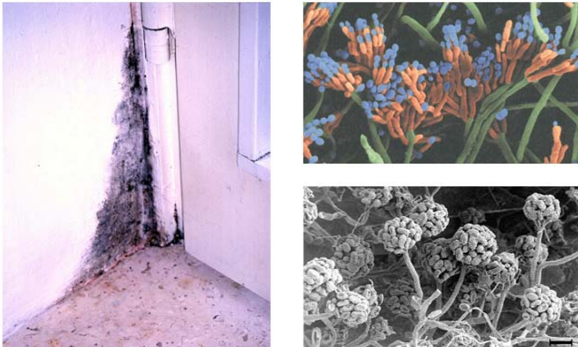
Bild 11 Fotografische Aufnahmen von Schimmelpilzen. links: Schimmelpilze als grauer Belag in einer Raumecke. rechts: Mikroskopische Aufnahmen von Schimmelpilzen.
