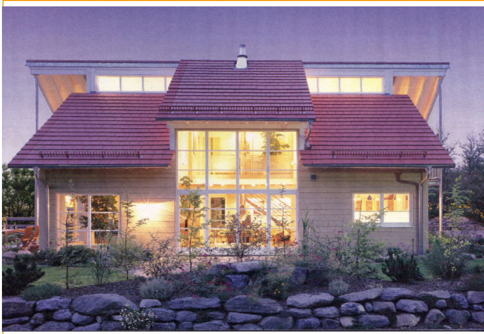
Abb.3.2-14: Konsequenter ökologischer Bau verbessert das Raumklima (Quelle: Fa. Baufritz, Erkheim/Allgäu)
