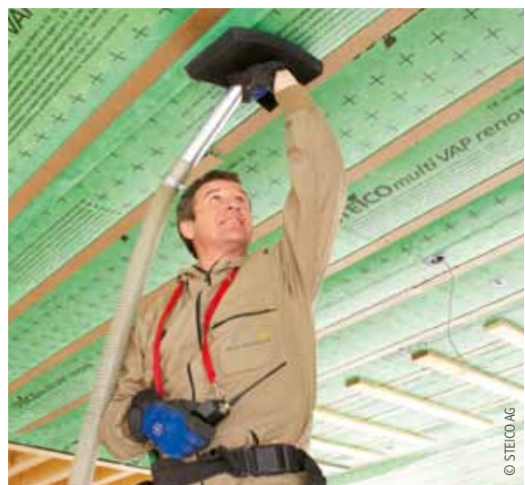
Dämmung der Zwischendecke mit Einblasdämmstoff
