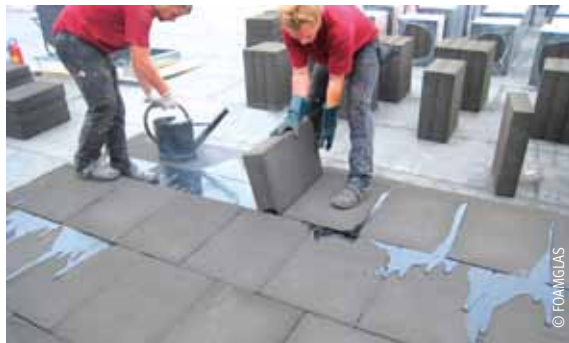
Verlegung von Glasschaumplatten
