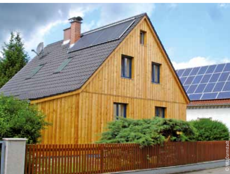
Holzfassade mit Boden-Deckel-Schalung
