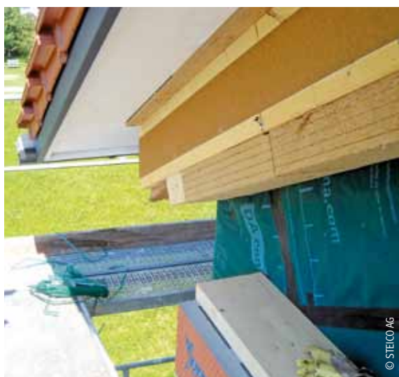
Detail einer Dachdeckung mit Holzfaserdämmung
