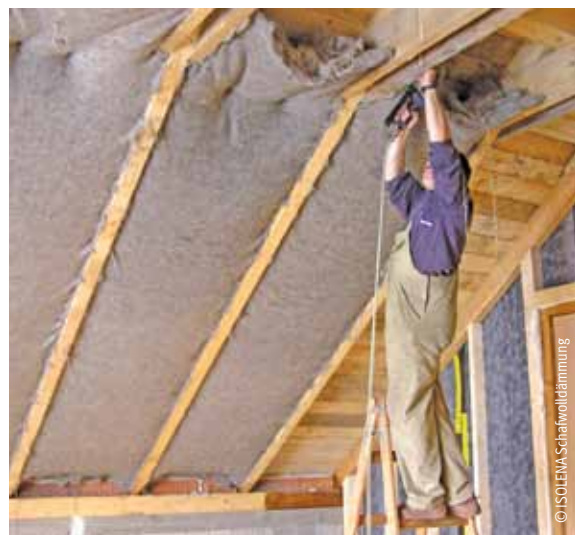
Dachdämmung mit Schafwollmatten
