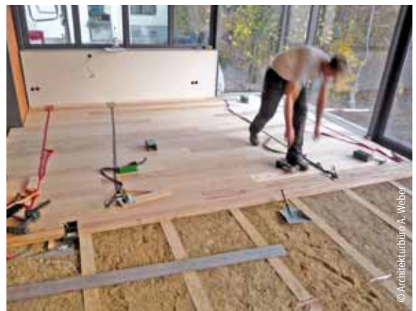
Ulmenmassivparkett auf Fußbodenheizung in Stampflehmbett
