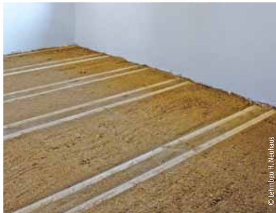
Hohlraumfüllung mit Lehm-Trockenschüttung
