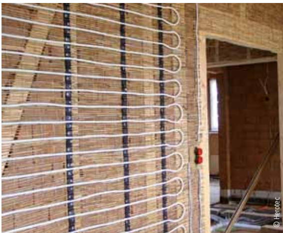
Wandheizung auf Schilfrohmatten
