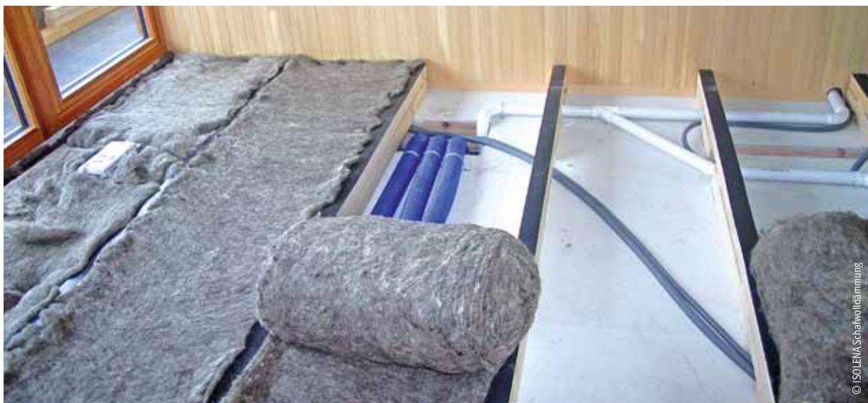
Fußbodendämmung mit Schafwollmatten
