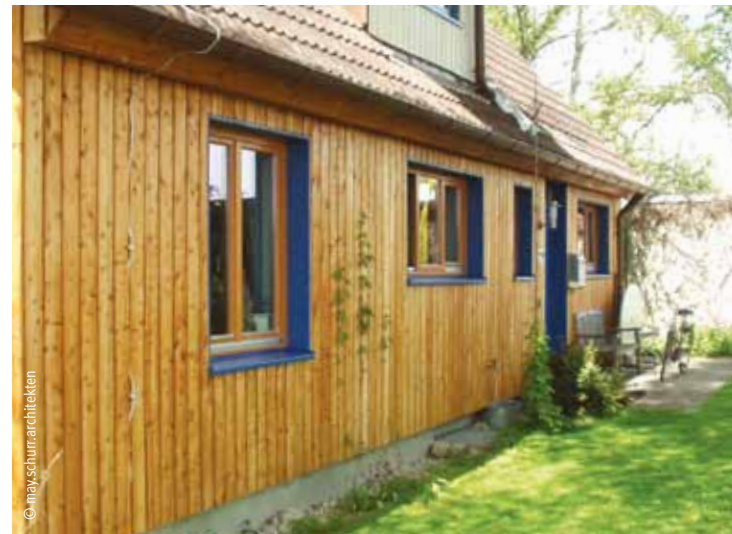
Einfamilienhaus in Apfeltrach: Hinterlüftete Vorhangfassade (rechts) mit Holzverschalung und Zellulosedämmung, Zellulose aufgesprüht in Konterlattung (links) 2 • 6 cm
