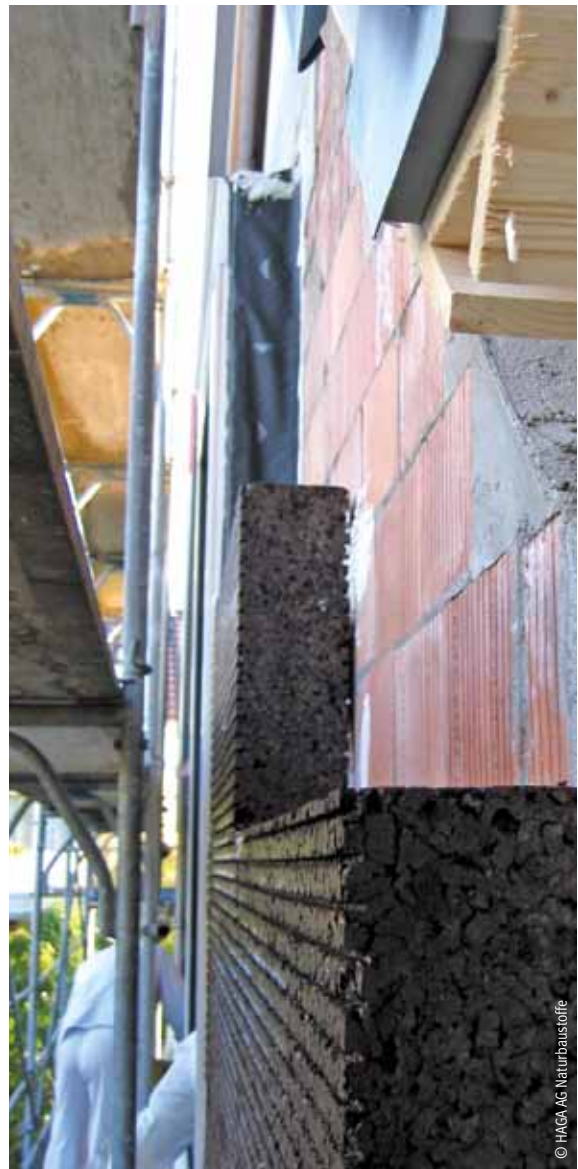
Korkdämmplatten als Fassadendämmung
