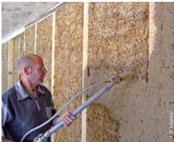
Aufbringen des Lehmputzes mittels Putzmaschine
