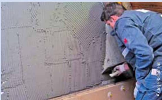
Lehmmörtel vollflächig mit Zahnkelle auftragen.
