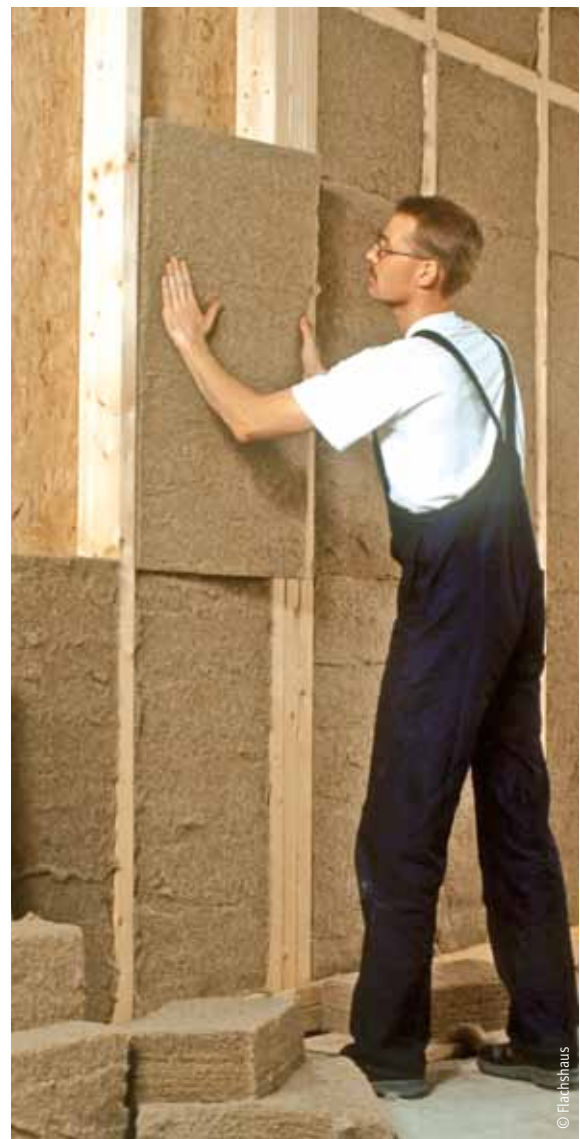
Ausfachung von Ständerwerk mit Flachsmatten
