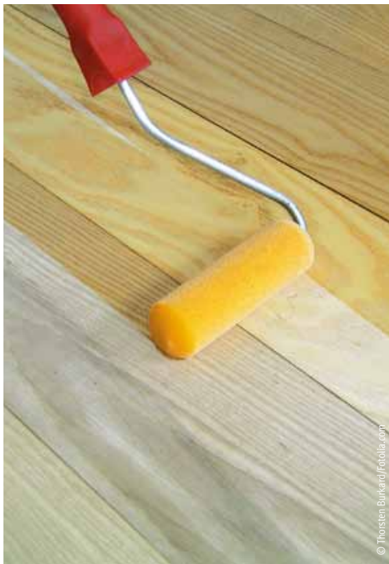
Auftrag von Fußbodenöl auf neuer Holzdielenung
