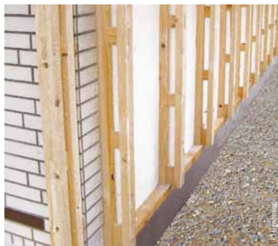
Traggerüst aus vorgefertigten Holzleitern (System Lignotrend)
