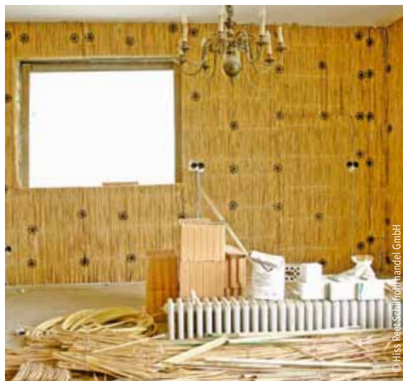
Mit Schilfplatten gedämmter Innenraum
