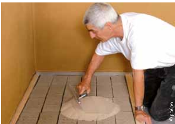
Auffüllen der Fugen mit Quarzsand
