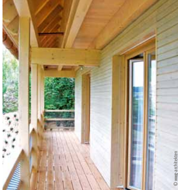
Ein ausladendes Dach schützt das Holz vor Witterung.
