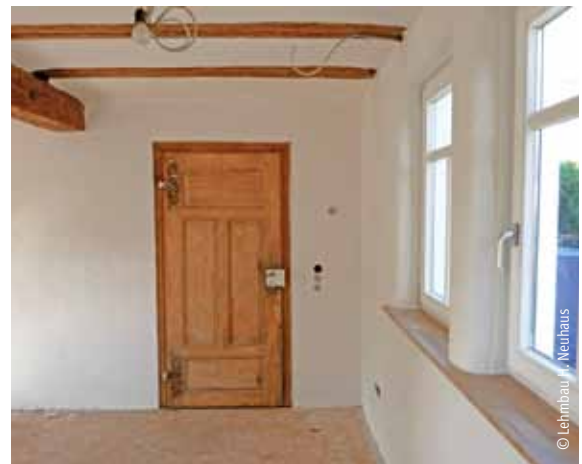
Reine Lehmputze bestehen lediglich aus Lehm, Sand und Wasser. Nach dem Austrocknen sorgen sie für ein gesundes Raumklima und wirken als Feuchtausgleich.
