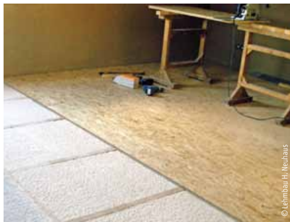
Hohlraumfüllung mit Perlite, Abdeckung mit OSB-Platten
