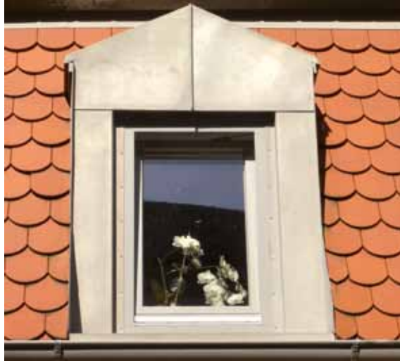
Gaubeneindeckung mit Edelstahlblech
