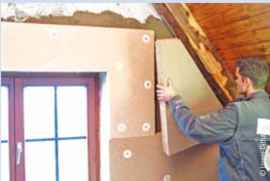
Dämmplatte stumpf an Balken stoßen.
