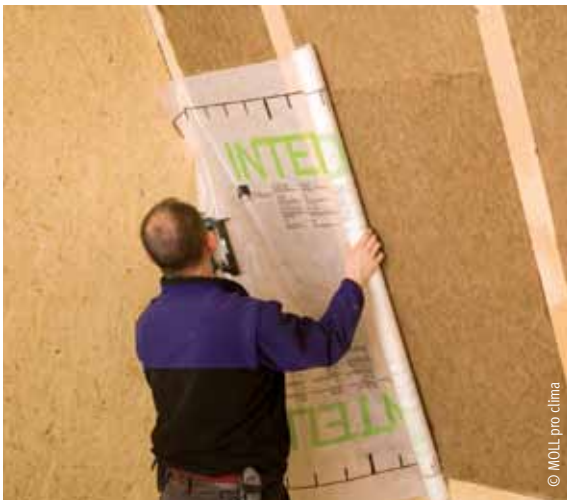
Raumseitiges Anbringen einer feuchteadaptiven („intelligenten“) Dampfbremse
