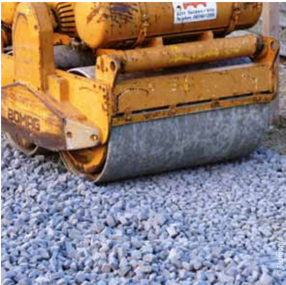
Schaumglasschotter als kapillarbrechende Wärmedämm- und Tragschicht
