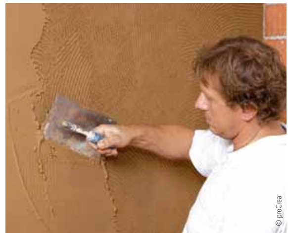
Auftrag des Oberputzes auf Grundputz
