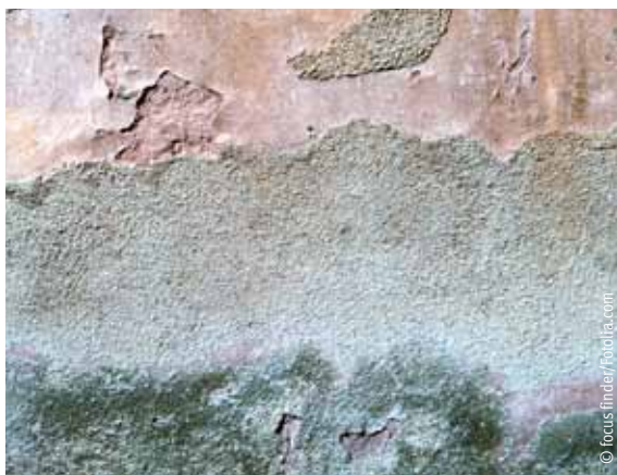
Schadhafte Putzoberfläche
