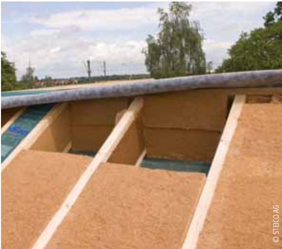
Einbau von flexiblem Dämmstoff von außen zwischen die Sparren
