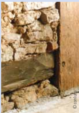
Lose und dampfsperrende Schichten von Wand entfernen. Wand gegebenenfalls trocknlegen.
