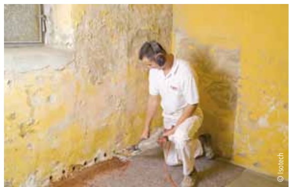
Vorbereitung zur Bohrlochtränkung
