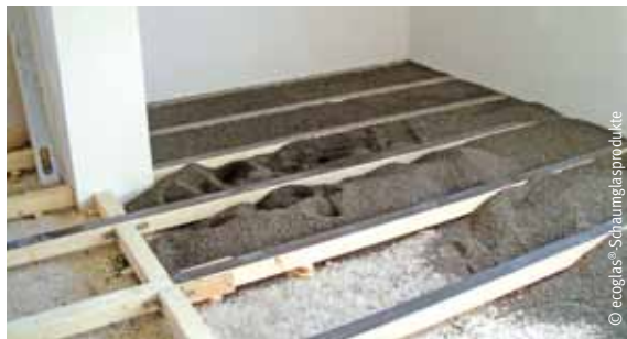
Auffüllen eines Hohlraumes mit Glasschaumschotter
