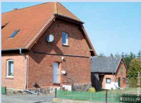
Ziegelsichtige Gebäudefassaden mit innenseitiger Dämmung
