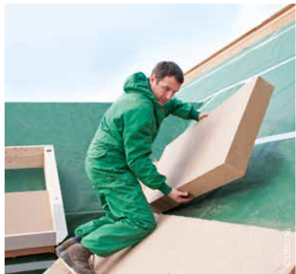
Aufbringen einer Aufsparrendämmung
