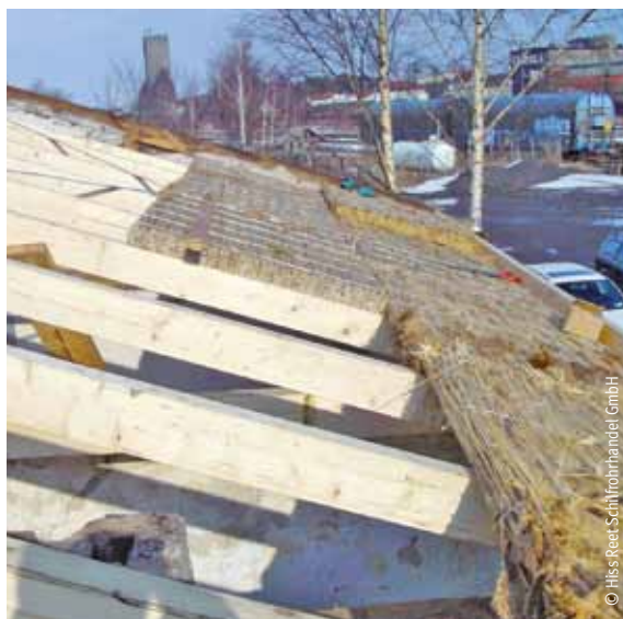
Aufdachdämmung mit Schilfrohrdämmplatten
