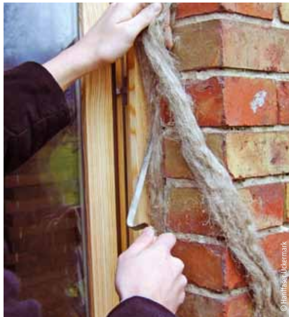
Ausstopfen von Bauteilfugen mit Hanf
