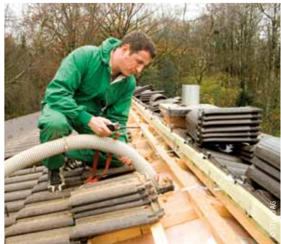
Einblasen von Dämmstoff
