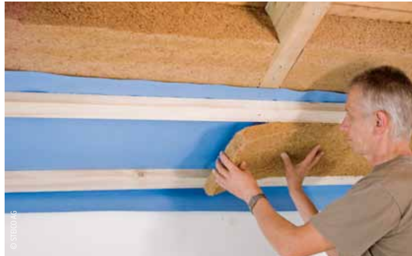
Ausfüllen der Installationsebene mit natürlichem Dämmstoff
