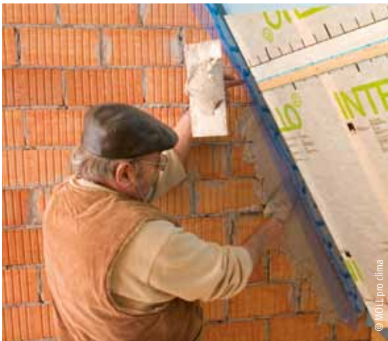
Einputzen des Dichtungsbandes
