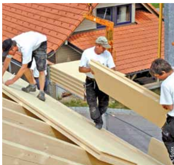
Wärmebrückenfreie Aufsparrendämmung mit wasserabweisenden Holzfaserdämmplatten
