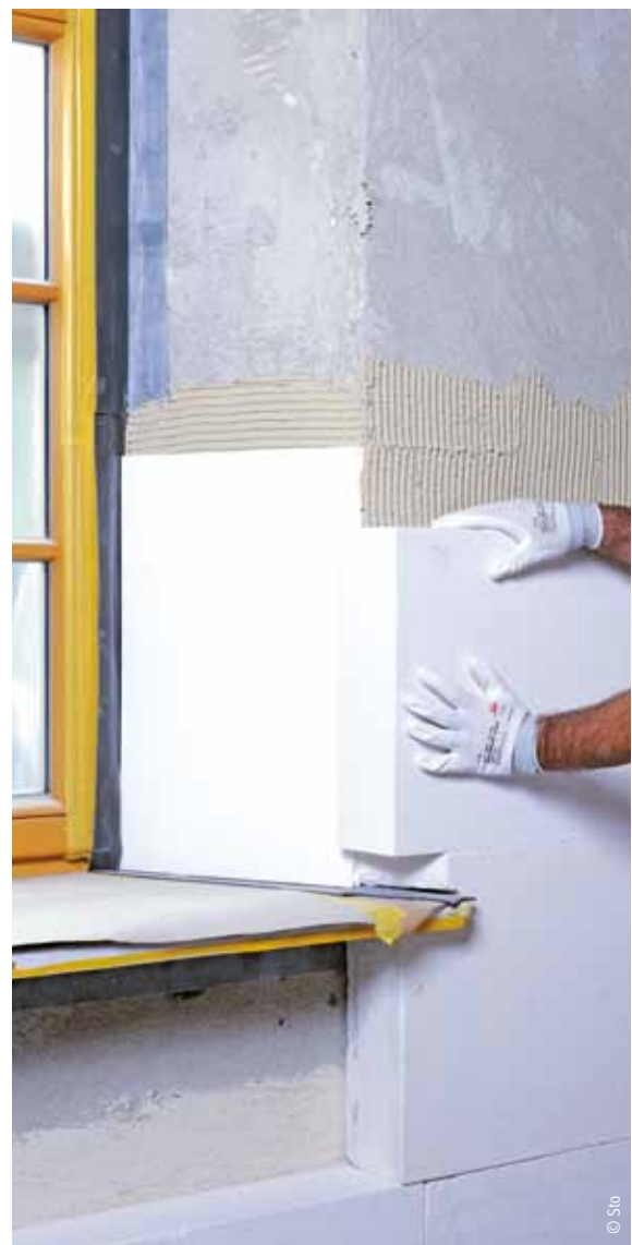
Innendämmung mit Perliteplatten
