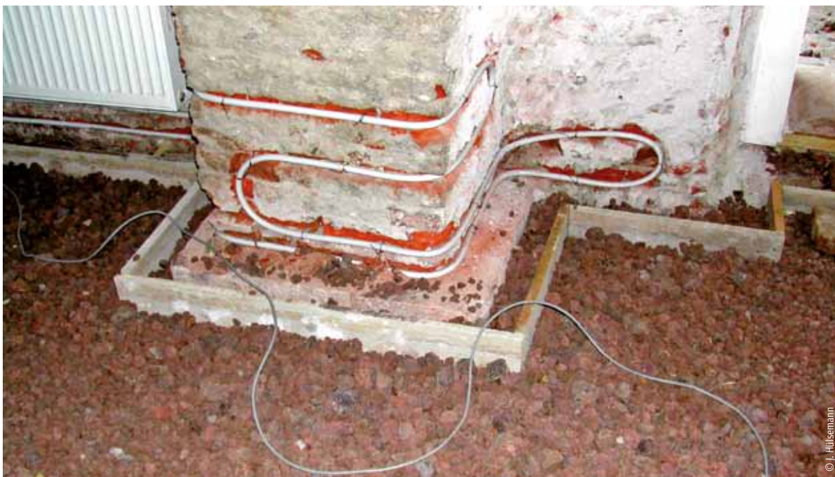
Bauteilheizung zur Trockenlegung von Außenwänden
