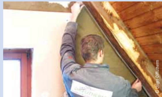
Kompriband einlegen für Anschluss an Sparren.
