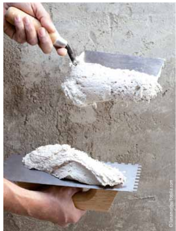
Gips wird mit einer Zahnkelle aufgetragen.
