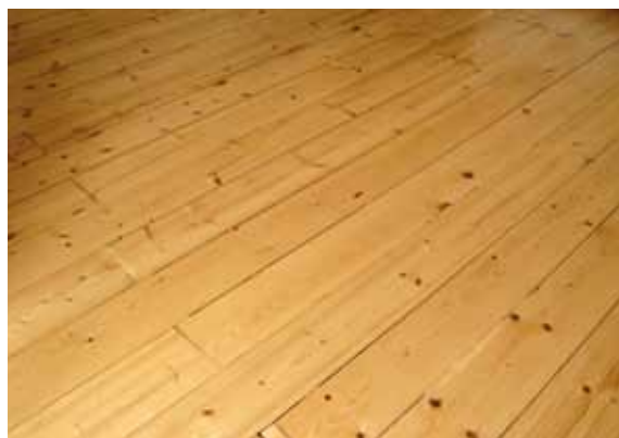
Dielenboden auf Lehmsteindecke
