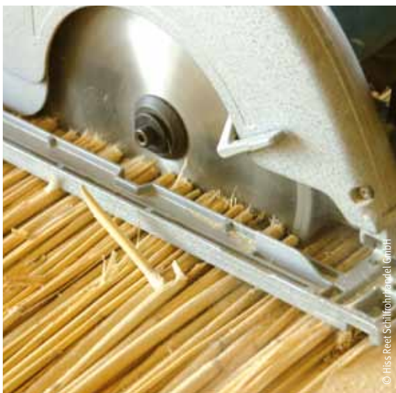
Zuschnitt von Schilfdämmplatten mit Handkreissäge
