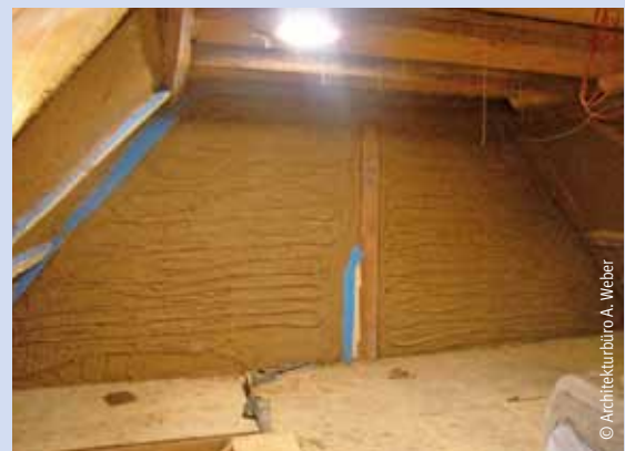
Einschlännen der Heizrohre in Lehmgrundputz
