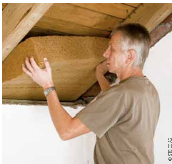
Einbringen einer flexiblen Dämmmatte
