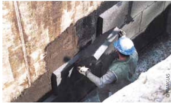
Befestigung von Glasschaumplatten an der Außenwand
