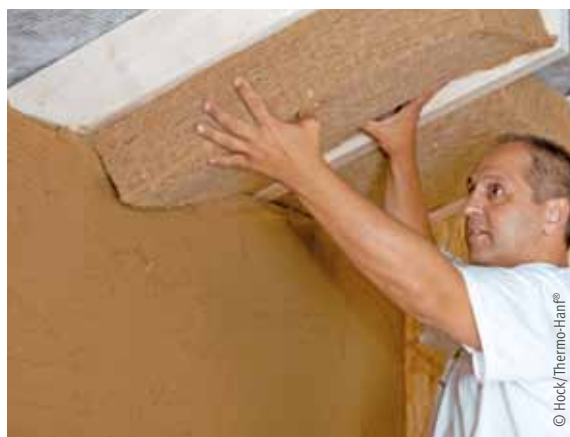
Dachdämmung mit Hanffasermatten
