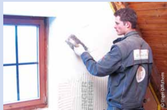
Armierungsgewebe in Kalk- oder Lehmputz einarbeiten.
