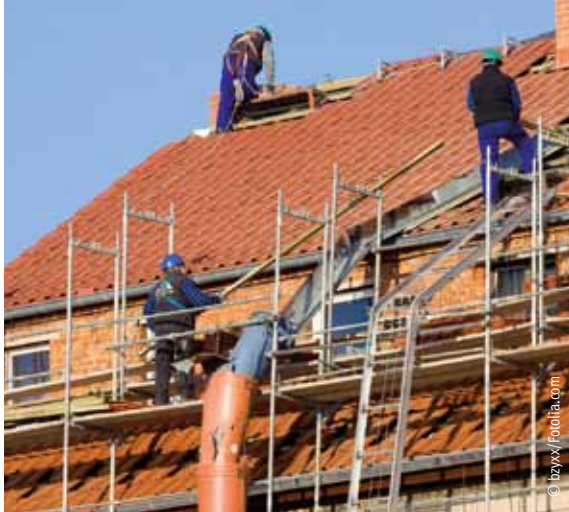
Dacheindeckung mit naturroten Falzziegeln
