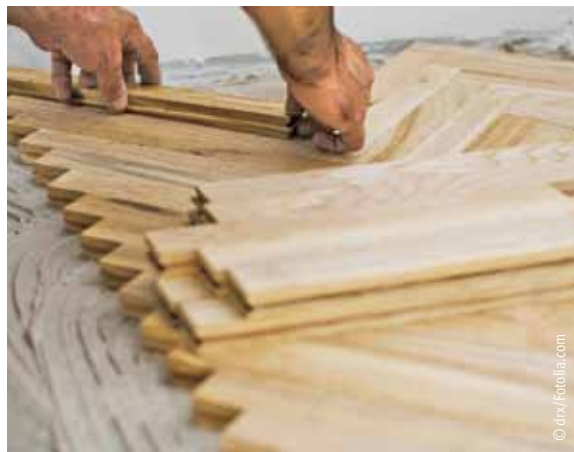
Verlegung von Stabparkett
