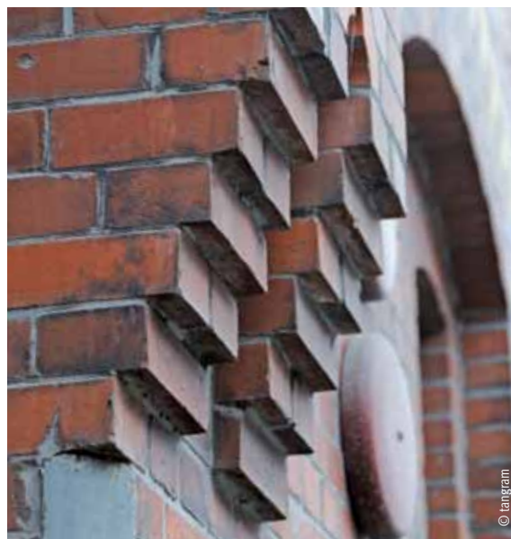
Detail eines Ziegelmauerwerks
