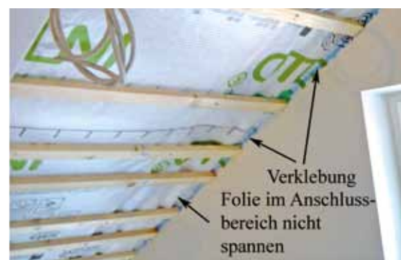
Dachdämmung mit Zellulose-Einblasdämmung und „intelligenter“ Dampfbremse. Bahnenstöße mit Klebeband abgeklebt und unter Dachlatten angeordnet. Luftdichter Anschluss der Bahnen an Gipskartonwand mit Systemkleber.
