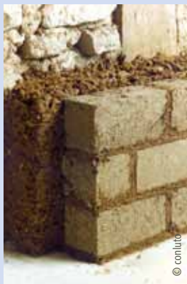
Wegen Reduzierung des Fugenanteils großformatige Steine bevorzugen.
