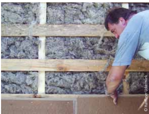
Innendämmung mit Hanfstopfwolle und verputzbarer Holzfaserplatte
