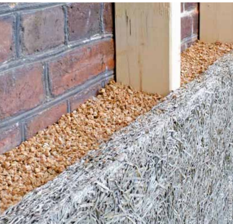
Außenwanddämmung: Korkschüttung mit Holzwolle-Dämmplatten auf Unterkonstruktion
