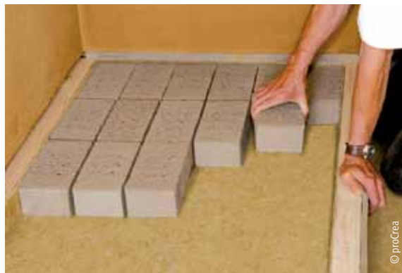
Einbau der Lehmsteine auf Hanffilzmatte (= schalltechnische Verbesserung)
