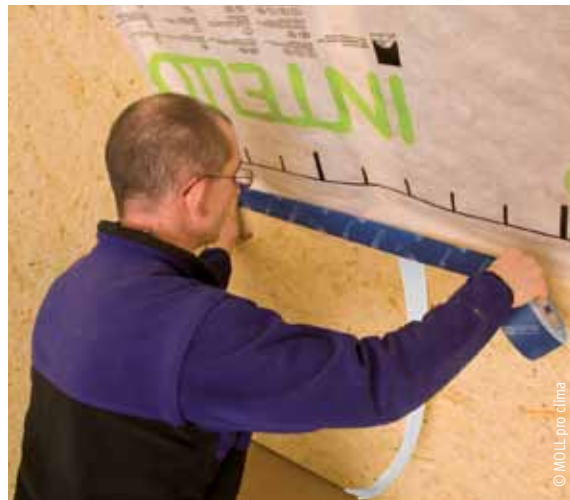
Anschluss an Drempelwand
