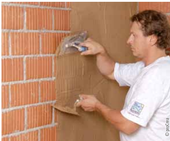
Auftrag des Grundputzes
