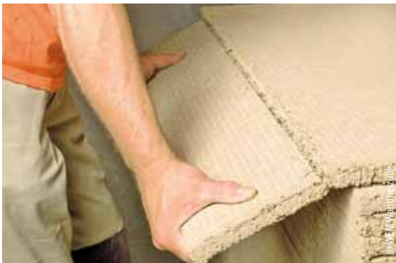
Ablängen einer Lehmbauplatte
