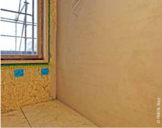
Lehmputz auf Mauerwerk
