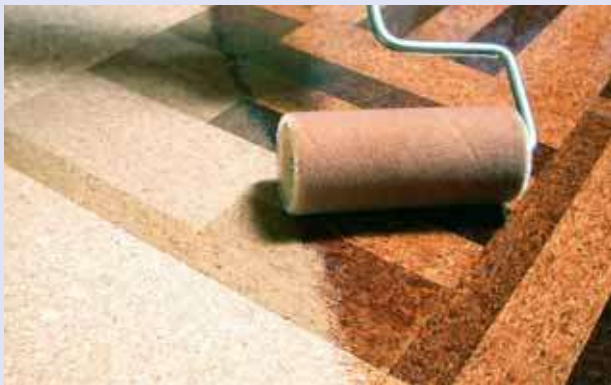
Einölen von Korkboden
