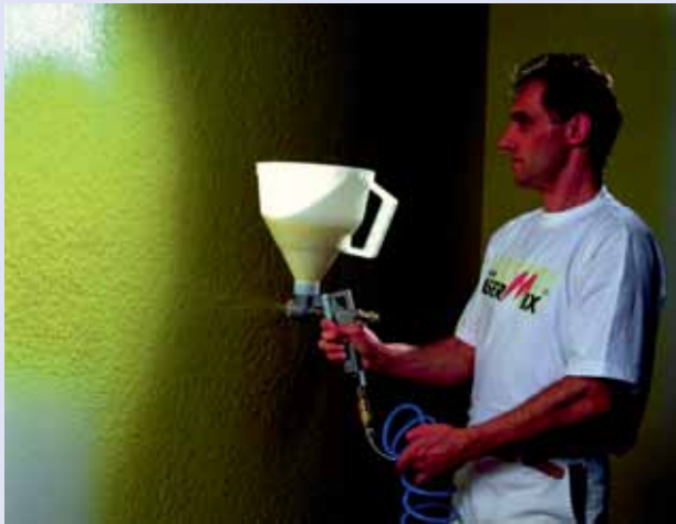
Faserputze aus Baumwolle, Spritztechnik
