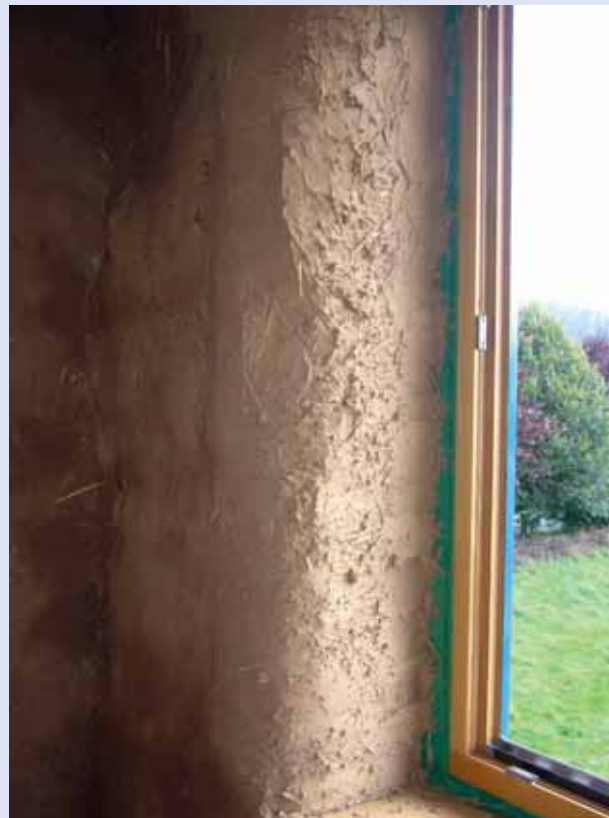
Strohballenhaus mit Lehm verputzt
