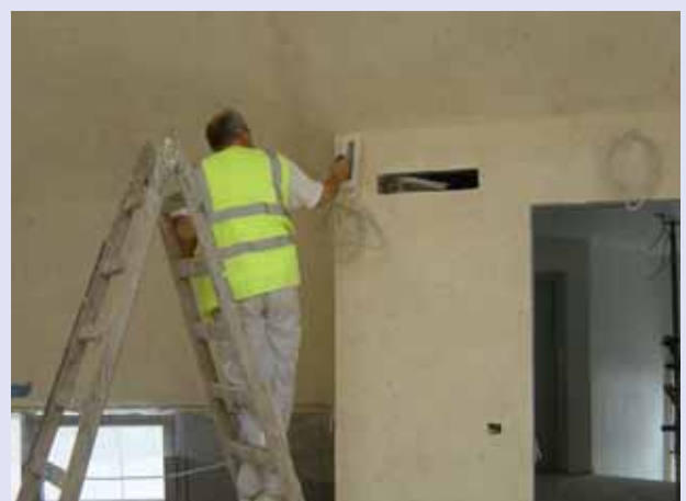
Faserputze aus Baumwolle, Glättetechnik
