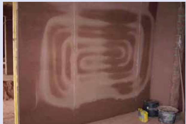
Wandheizung auf OSB mit Lehm verputzt
