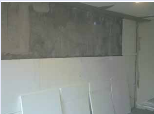
Sanierung eines Dämmschadens mit rein mineralischen Dämmplatten
