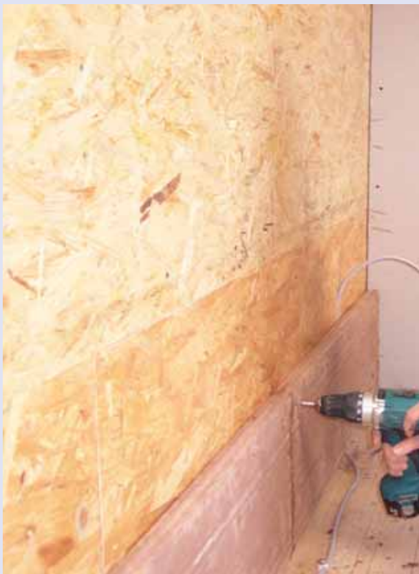
Lehmputzträgerplatte auf OSB im Holzbau
