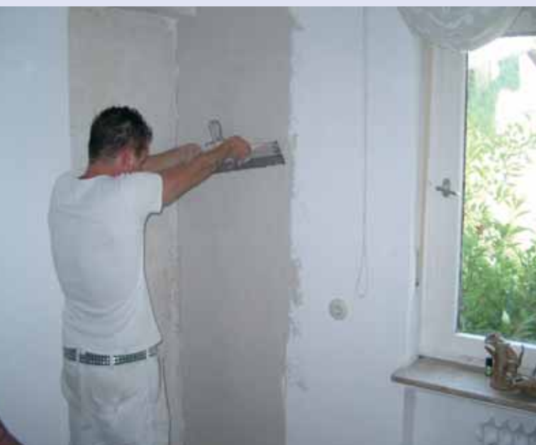
Kalkdämmputz nach Sanierung
