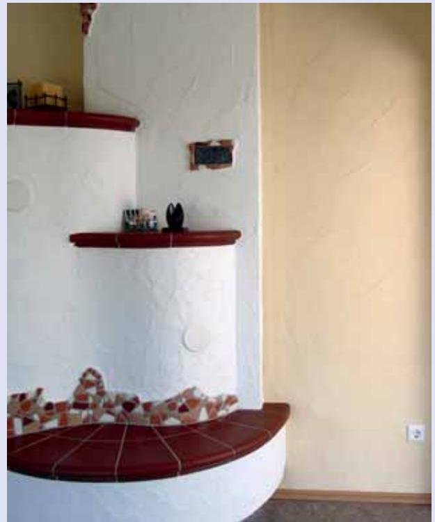
Ofen und Wand mit Kalkputz
