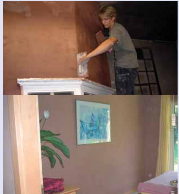
Aufbringen von Lehmputz oder Lehmputz natur
