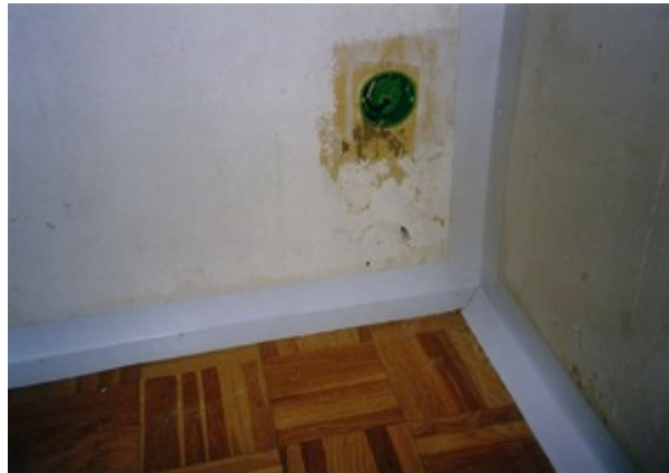
Bild 70: IQUH PCP- Absperrung mit Alu- Tapete und - Band
