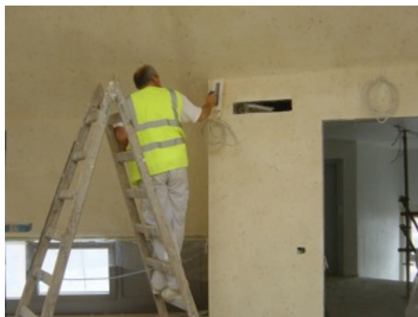
Bild 59: Fa. Fasermix, Faserputze aus Baumwolle, Glättetechnik
