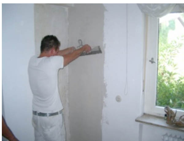
Bild 72: Fa. Klimasan, Kalkdämmputz nach Sanierung
