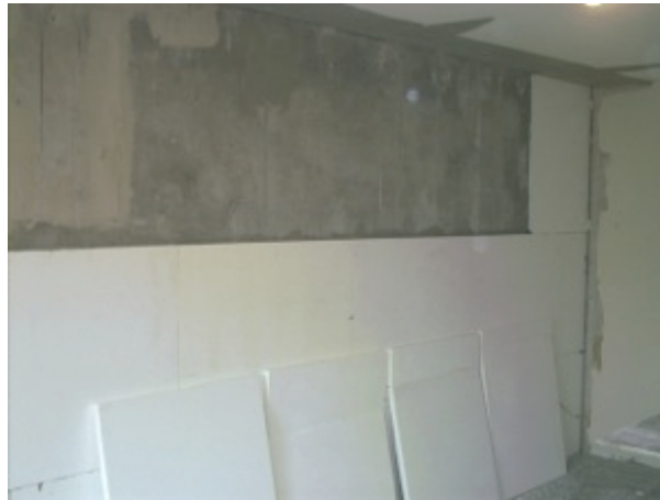
Bild 15: Methner, Klaus: Sanierung eines Dämmschadens mit rein mineralischen Dämmplatten
