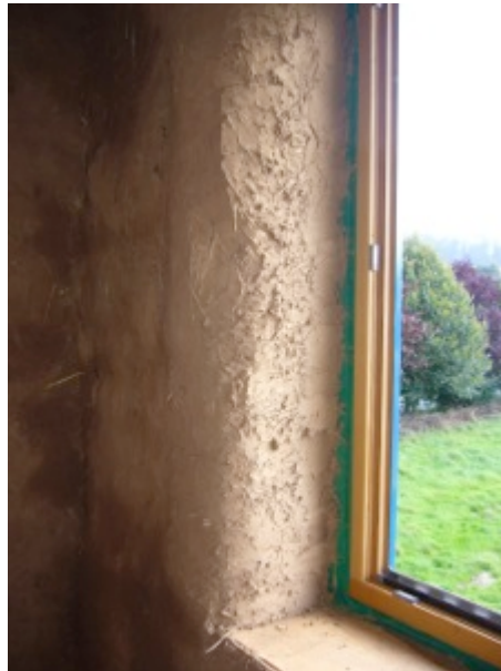
Bild 48: Pilosith -Strohballenhaus mit Lehm verputzt
