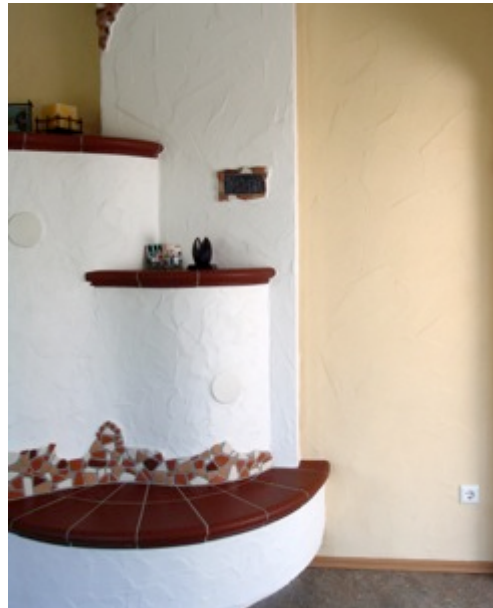
Bild 02: Fa Haga- Ofen und Wand mit Kalkputz
