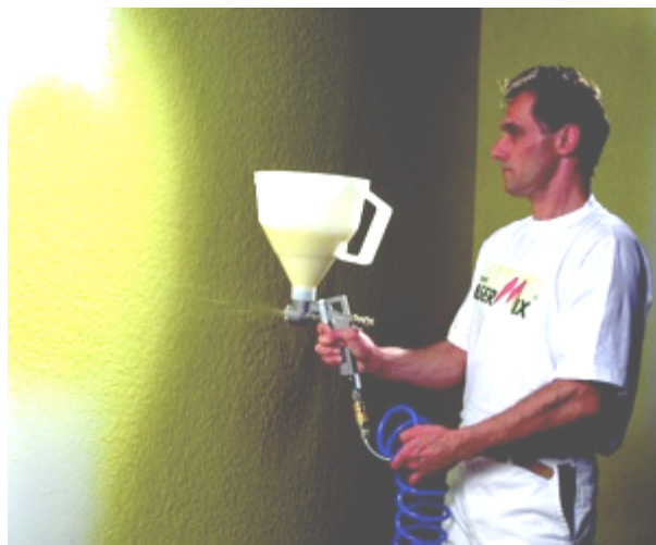
Bild 60: Fa. Fasermix, Faserputze aus Baumwolle, Spritztechnik
