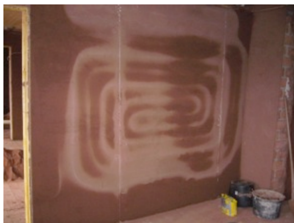
Bild 09: Pilosith Wandheizung auf OSB mit Lehm verputzt
