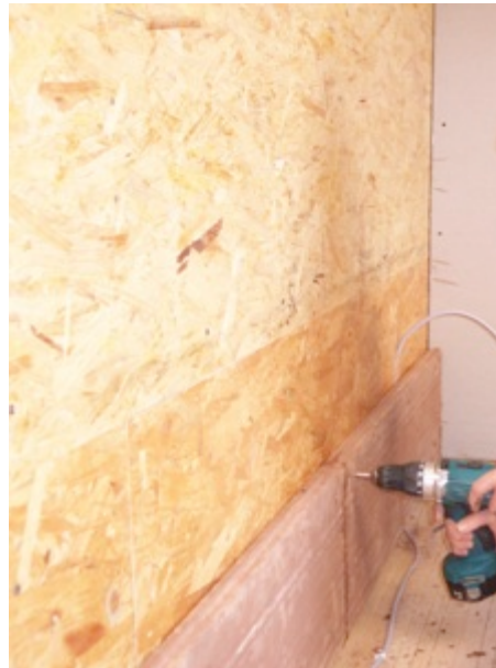
Bild 29: Pilosith - Lehmputzträgerplatte auf OSB im Holzbau
