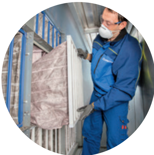
Ausbau eines gebrauchten Luftfilters
