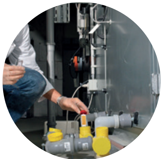
Kontrolle der Keimbelastung mittels Dip Slides
