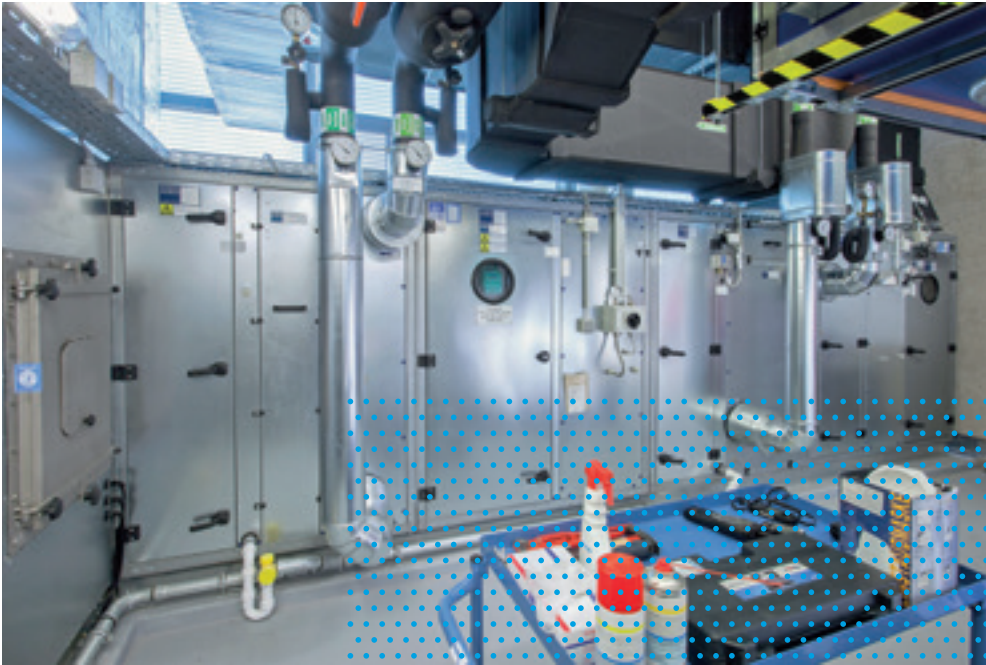
Bauelemente in der Lüftungszentrale müssen gefahrlos zugänglich sein
