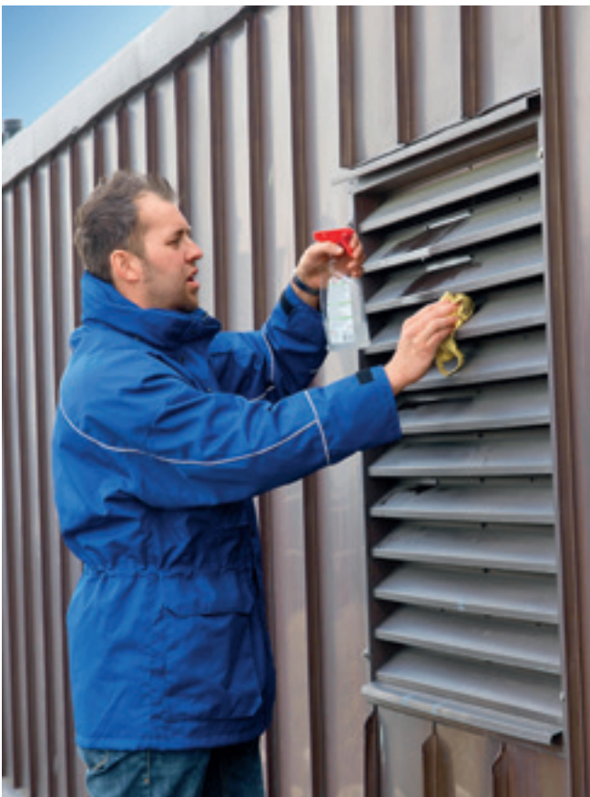
Reinigung einer Außenluftansaugöffnung
