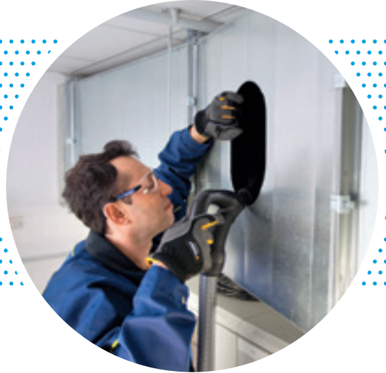
Reinigung einer Luftleitung
