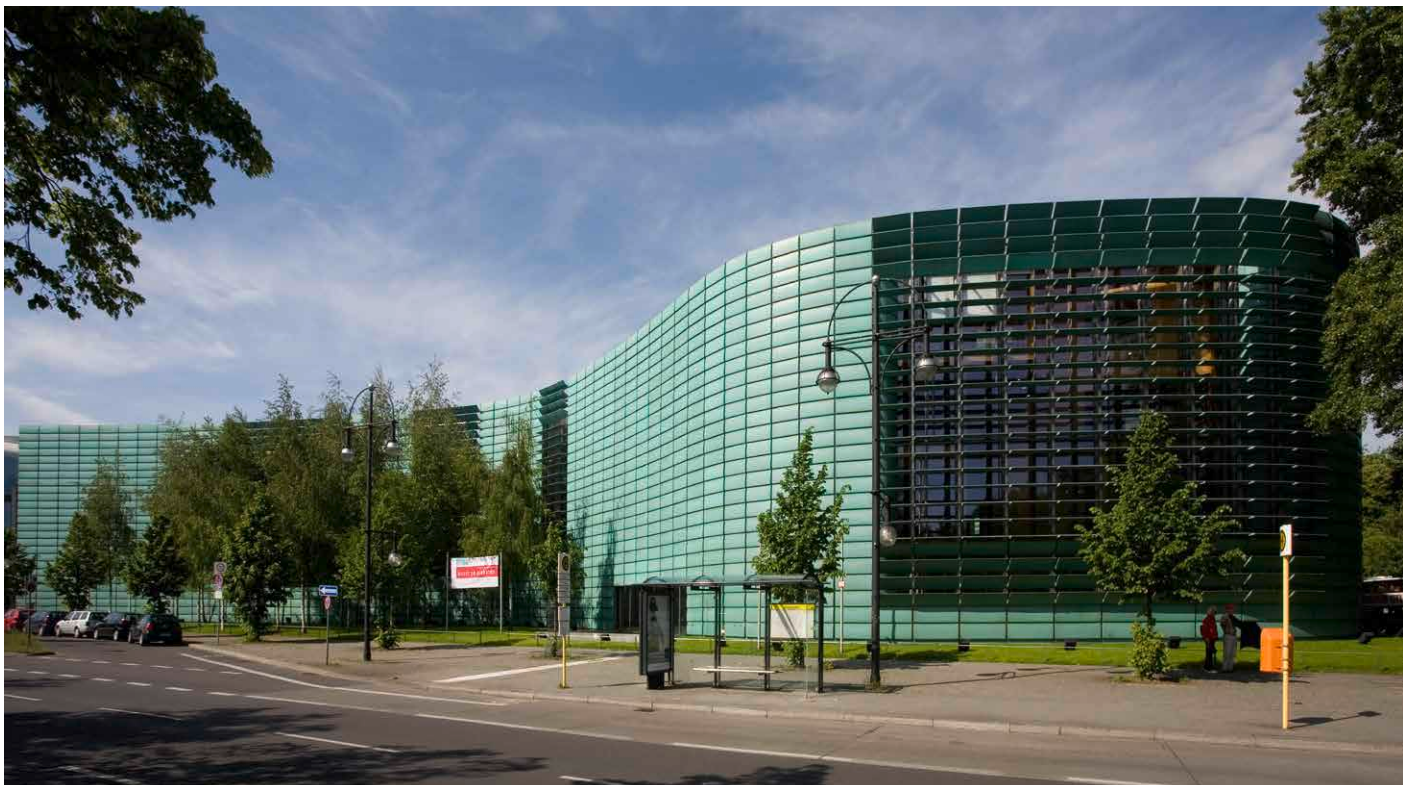
Bild 14 Fassade aus vorpatinierten Kupferlamellen.
